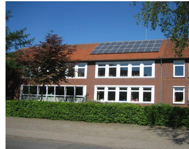
Photovoltaikanlage auf dem Schuldach
